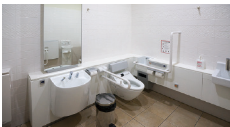
トイレ、汚物処理室
